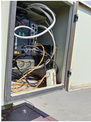
Uraian: Harwat switch camera (PoE) outdoor dan splicing jaringan FO yang putus PAM MAKO Keterangan: Juli 2025
