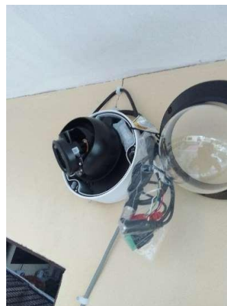
Uraian: Harwat Indoor Dome Camera CCTV PAM MAKO Keterangan: Maret 2025
