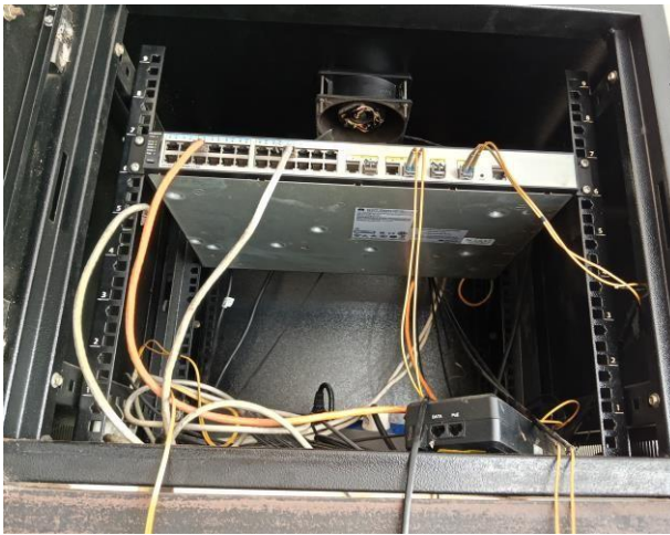
Uraian: Harwat switch camera (PoE) Indoor dan Indoor Dome Camera PAM MAKO Keterangan: Juli 2025
