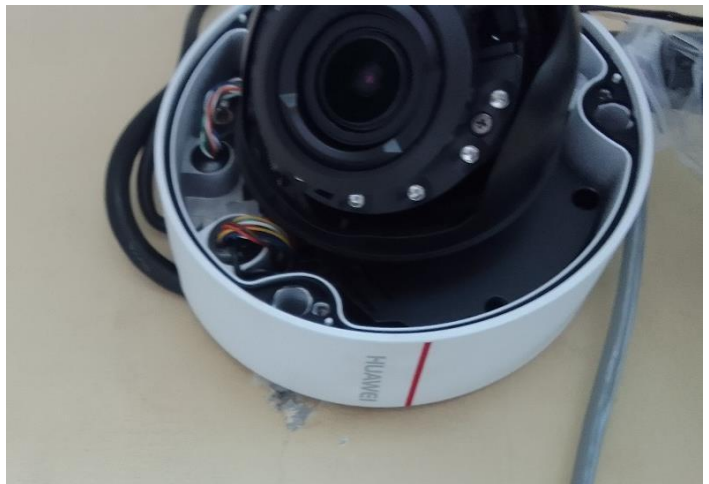
Uraian: Harwat switch camera (PoE) Indoor dan Indoor Dome Camera PAM MAKO Keterangan: Juli 2025
