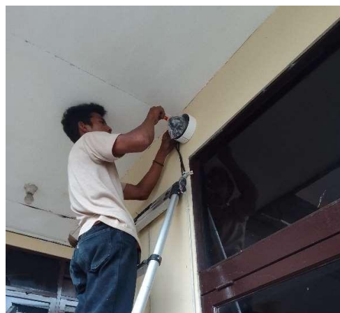
Uraian: Harwat Indoor Dome Camera CCTV PAM MAKO Keterangan: Maret 2025
