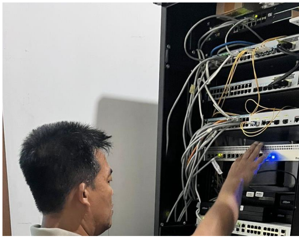
Uraian: Harwat Server untuk Lokal, WAN Router dengan Firewall, dan Switch Camera Aggregation 28 Port COMMAND CENTER Keterangan: September 2025
