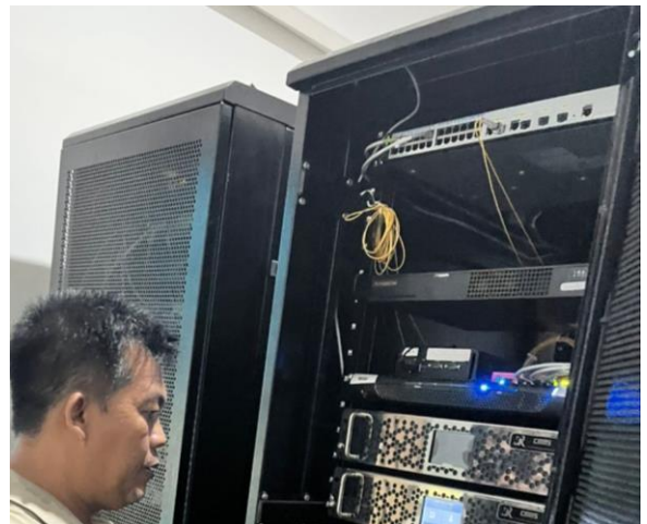
Uraian: Harwat Server untuk Lokal, WAN Router dengan Firewall, dan Switch Camera Aggregation 28 Port COMMAND CENTER Keterangan: September 2025
